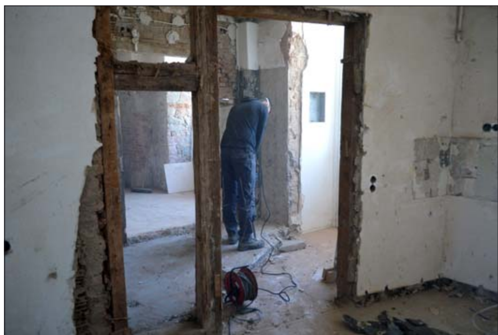
Mit schwerem Gerät sind Arbeiter gerade dabei, die Grundrisse der Räume für die geplante zukünftige Nutzung zu verändern.
